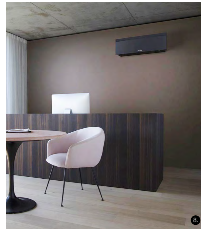
6. Klimatyzacja Daikin Emura 4 CLIMAT | poziom 0
